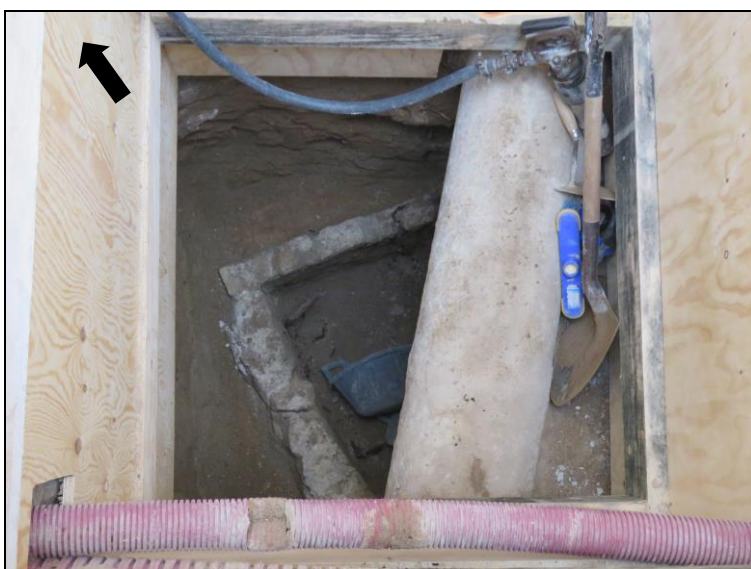
Vista zenital del dipòsit UE 118 durant el procés d'excavació
