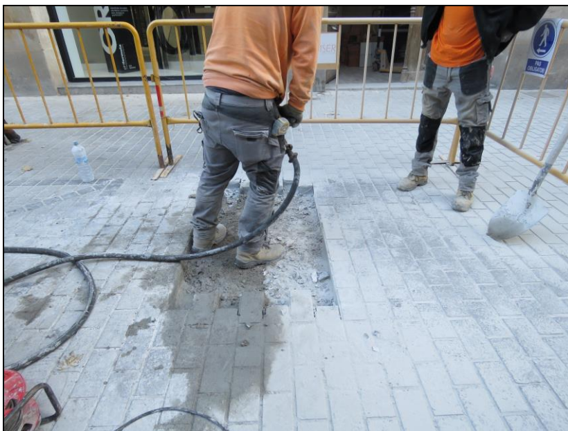
Inici de la intervenció marcant la rasa a excavar
