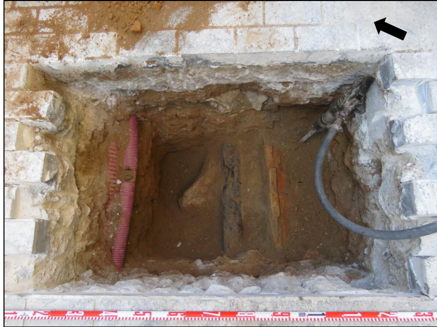
Vista general de la canalització de ferro i la claveguera
