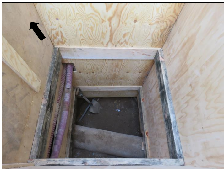
Vista interior del pou un cop encofrat amb fustes
