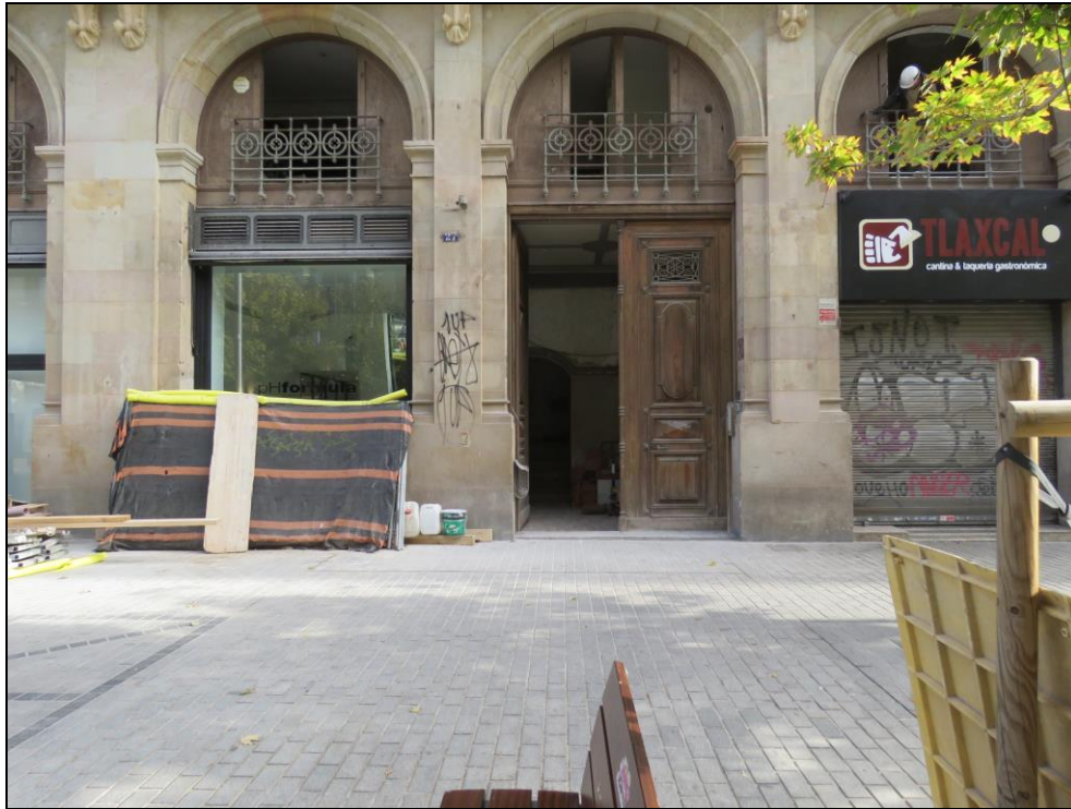
Vista general del sector d'intervenció
